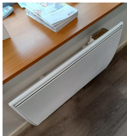
Fig 8 : Convecteur électrique
