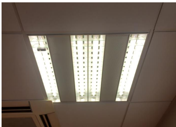
Fig 9 : Luminaire type fluo (4x14 W)
